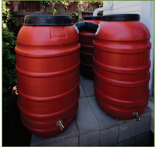
3. Si el bajante pluvial corre por una pared, deberá acortarse y agregar un codo para que se extienda hasta llegar a la parte superior del barril de lluvia.
